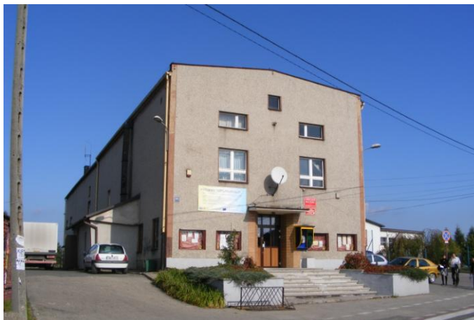
Zdj. nr 11 – Budynek Ośrodka Kultury w Gołkowicach
