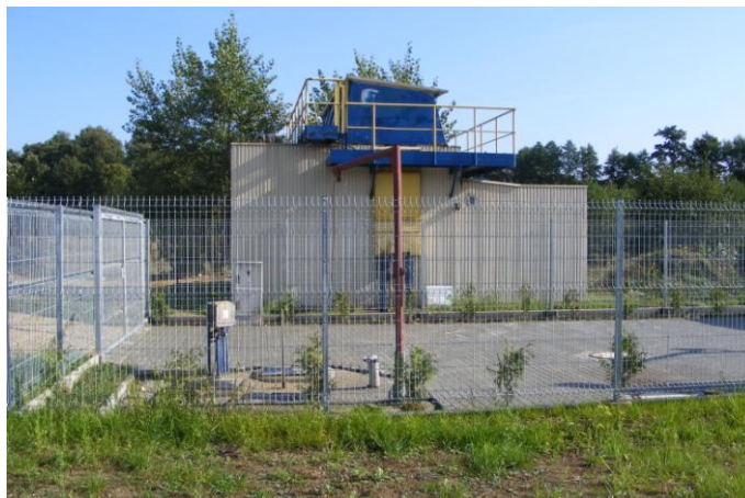
Zdj. nr 8 – oczyszczalnia ścieków
