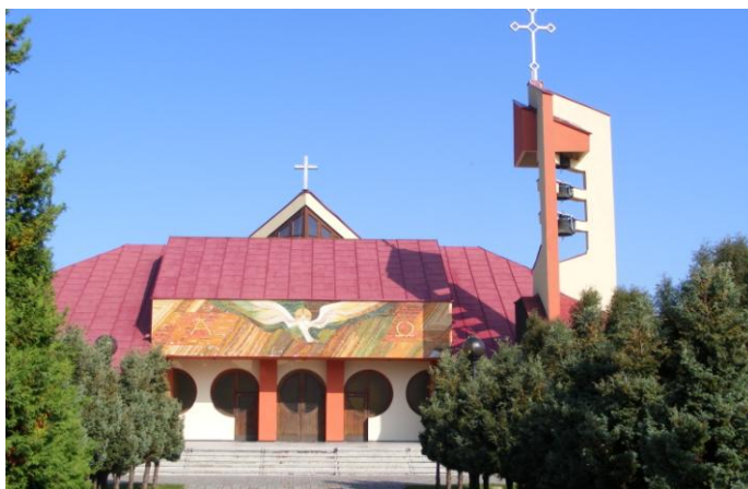
Zdj. nr 1 – Kościół pw. Podwyższenia Krzyża Św. W Gołkowicach
