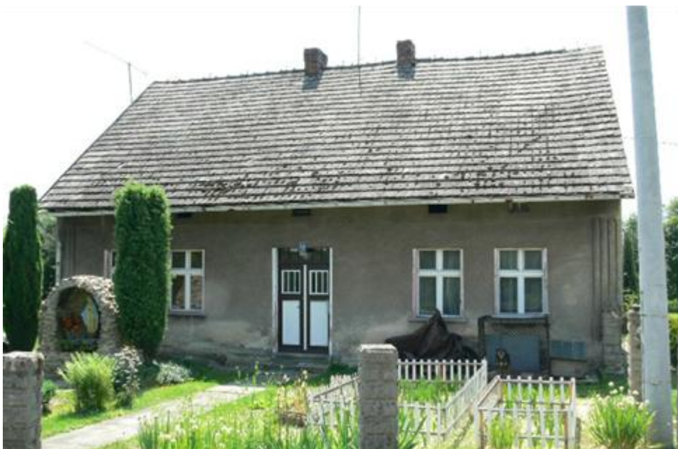
Zdjęcie 4- Budynek mieszkalny – ul. Dębowa
