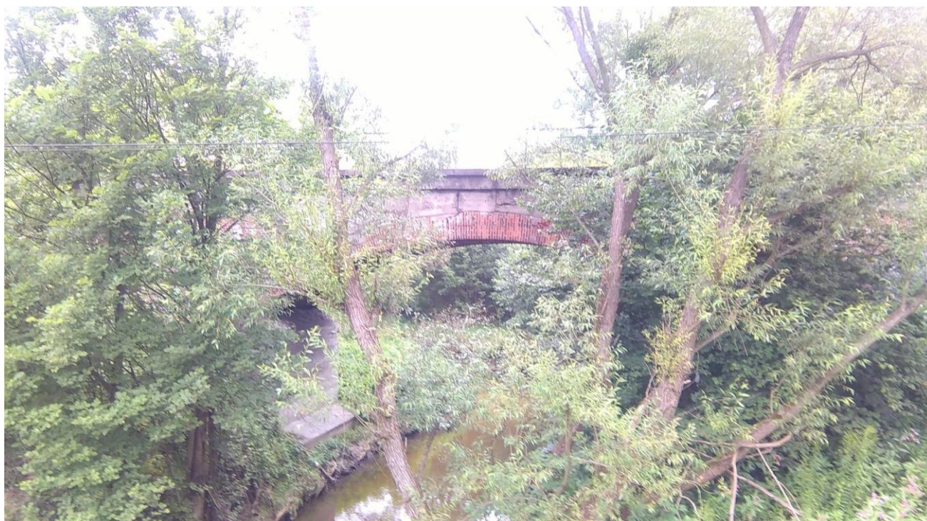
Ilustracja 36: Godów most kolejowy nad rzeka Leśnicą
