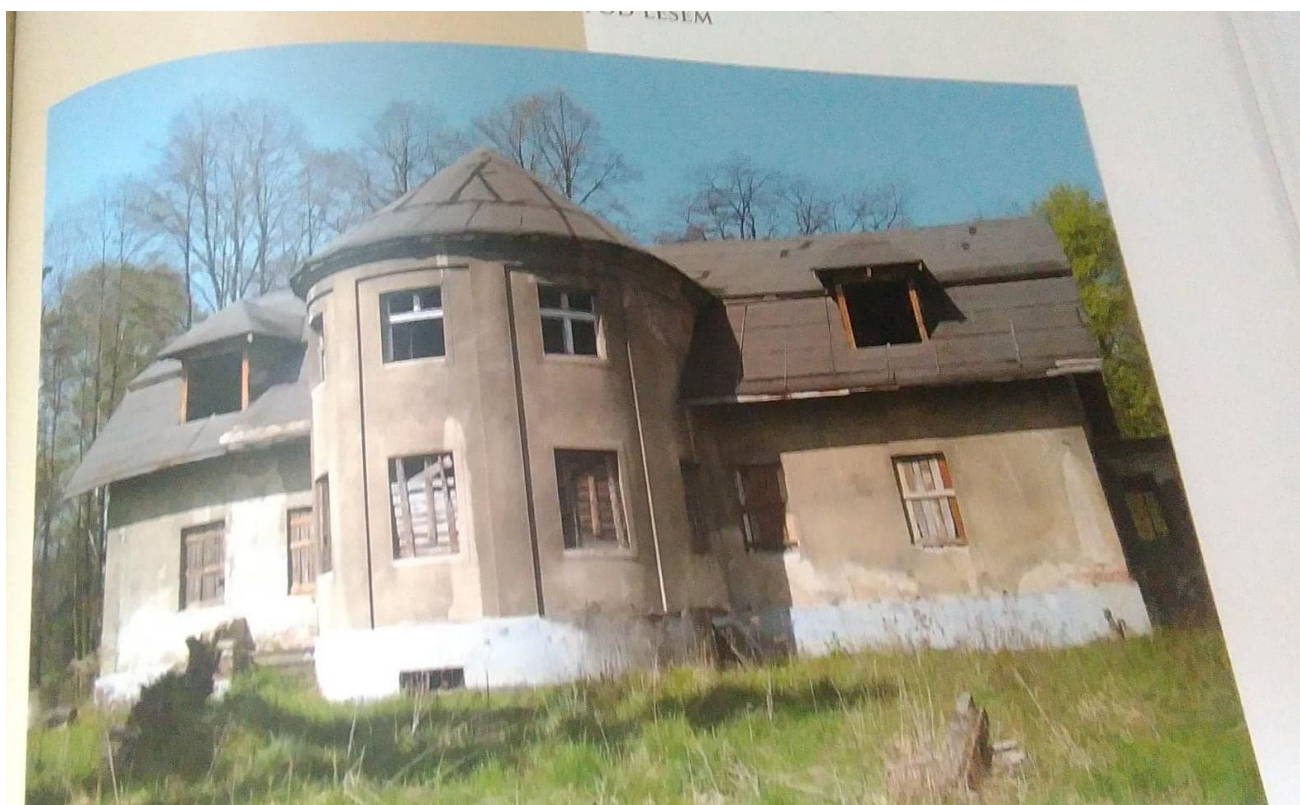
Ilustracja 47: Łaziska – Leśniczówka na ul. Leśnej przed remontem zdjęcie archiwalne
