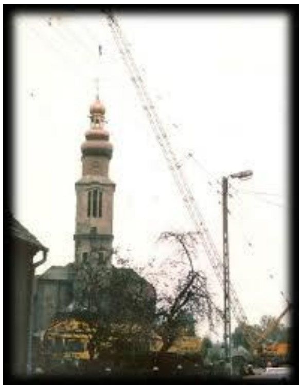
Ilustracja 73: Zdjęcie odbudowy wieży w kościele w Skrzyszowie
