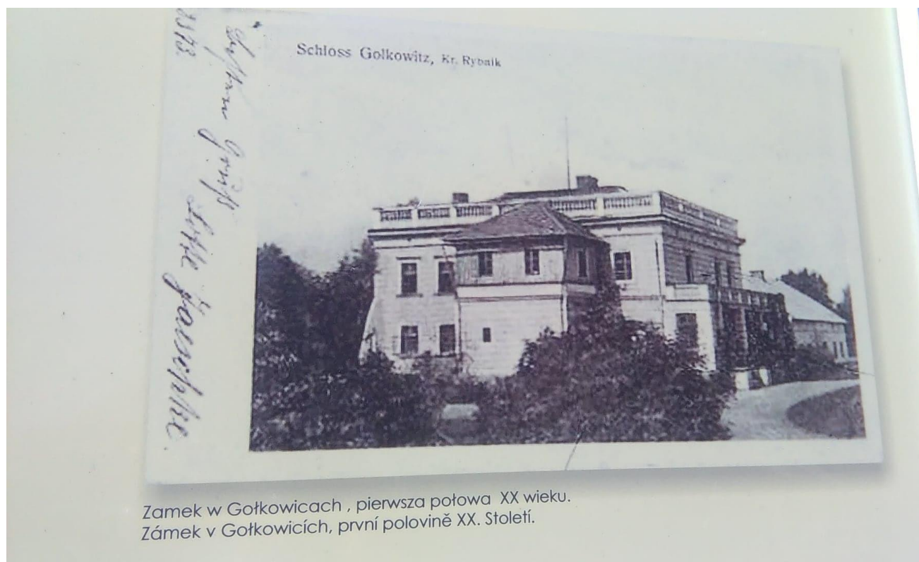
Ilustracja 12: Archiwalne zdjęcie Zamku w Gołkowicach w rejonie ul. Powstańców 11
